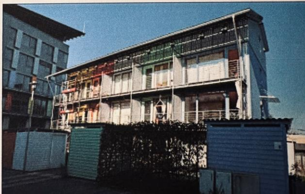
Abb. 2: Südfassade mit thermischer Innendachsolar-Anlage, Vordach mit Fotovoltaikanlage
