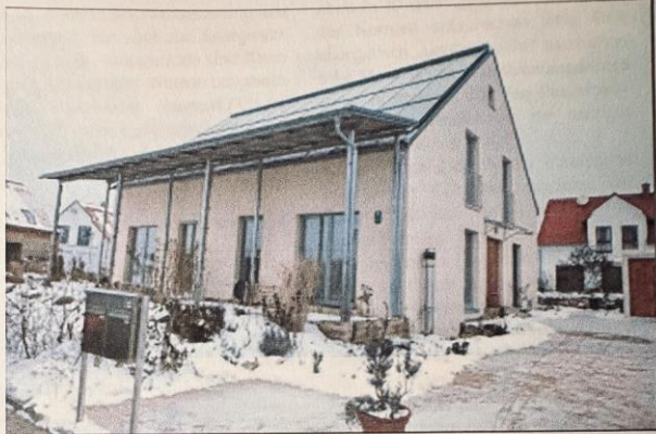
Abb. 2: Südfassade mit thermischer Innendachsolar-Anlage, Vordach mit Fotovoltaikanlage
